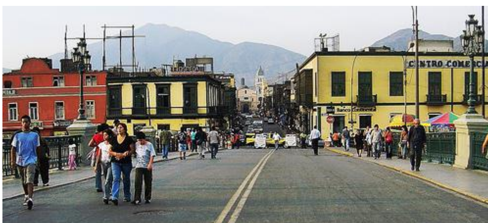
Figura N° 33.- imagen de la zona de inicio del corredor desde el Puente a la Alameda de los Descalzos y el Paseo de las Aguas
